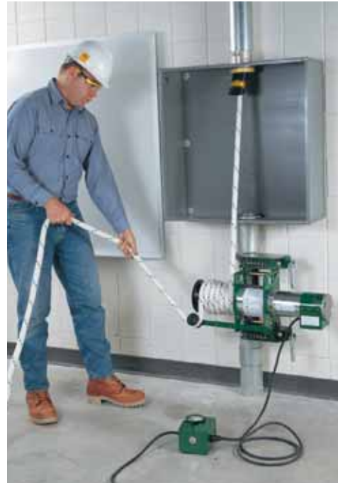
Вытягивания кабеля вниз с помощью устройства на платформе, прикрепленной цепями к трубопроводу.
