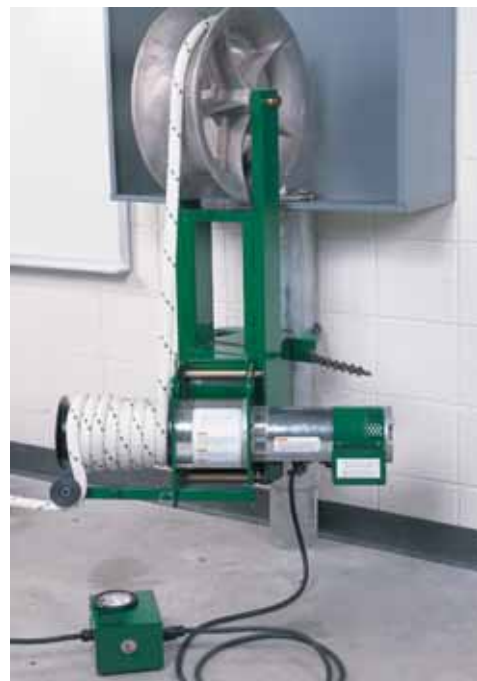
Вытягивание кабеля вверх с помощью устройства Ultra Tugger и направляющего ролика, установленных на трубопроводе.
