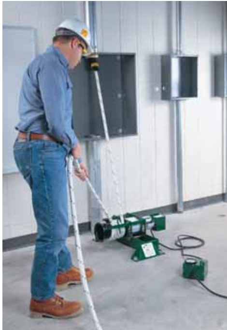
Вытягивание кабеля вниз с помощью устройства на платформе, прикрепленной к полу.
