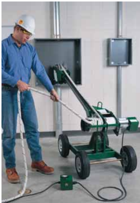
Вытягивание кабеля вверх с помощью устройства Ultra Tugger, установленного на передвижной тележке.
